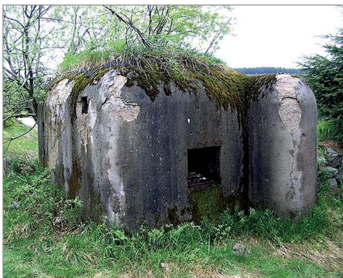
Obr. 4.2 Objekt bunkru lidově označovaného jako „Řopík“ podle zkratky „ŘOP“ (Ředitelství opevňovacích prací) budovaný na konci 30. let 20. století
