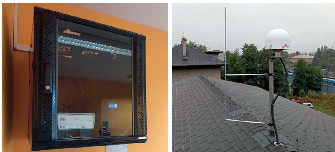
Obr. 2.2 Nová stanice CZEPOS v Olomouci (vlevo přijímač, vpravo anténa)
